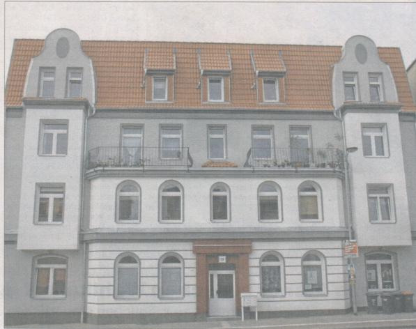
Die wärmedämmte Fassade präsentiert sich in einem plastischem Aussehen und ist ein echter Hingucker geworden. Foto: gk
