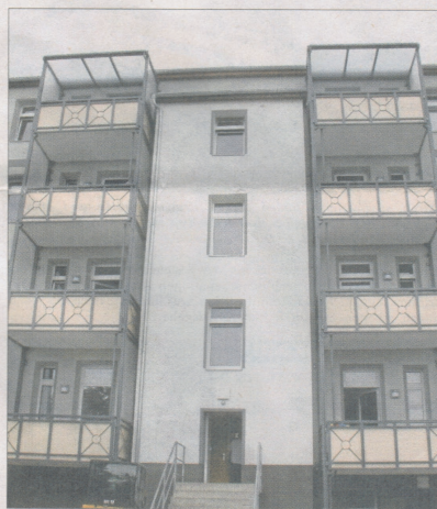
Alle acht Wohnungen verfügen nun über einen neuen Balkon, der über die Küche durch eine neue in die Fassade eingesetzte Balkontür zu erreichen ist. Foto: gk
