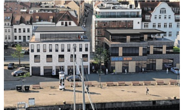
In den rechten Neubau wird der „Blaue Esel“ einziehen.
