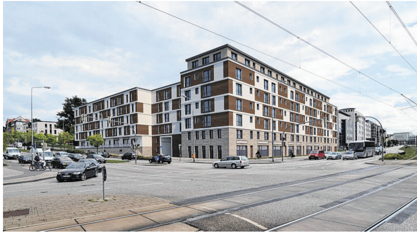
„City-Entwicklungsbereich Karlstraße“ heißt das Bauprojekt auf der Brachfläche neben dem Gebäude der RGS Am Vögenteich, Ecke August-Bebel-Straße, in dem 89 neue Wohnungen entstehen sollen.
